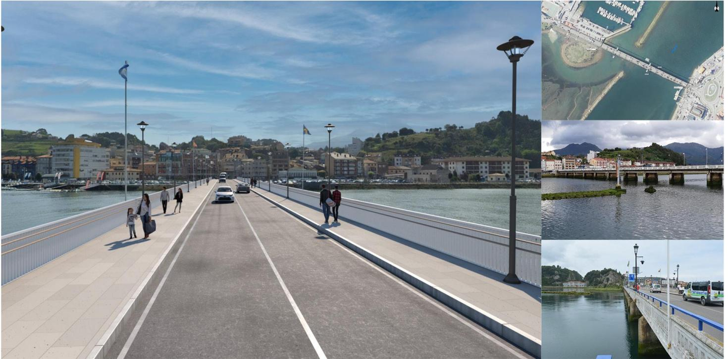
FHECOR junto con NOEGA Ingenieros, realizaron la redacción del proyecto, el cual consistió en la sustitución completa del tablero y su ensanche con el mantenimiento del tráfico durante los trabajos, la reparación y refuerzo para las nuevas cargas de la subestructura del puente y el ensanche de los accesos al puente desde ambas márgenes del río. Adicionalmente, se procedió al diseño, acorde a la normativa de accesibilidad en vigor, de los accesos desde las zonas aledañas.
